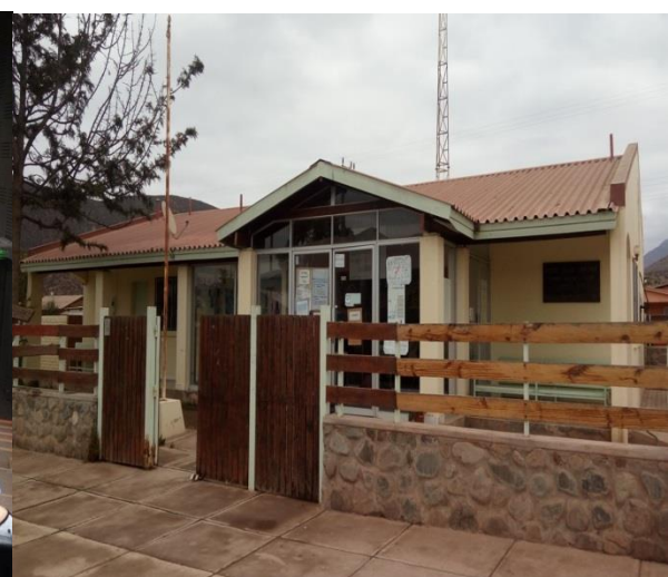
Supervisiones en terreno
